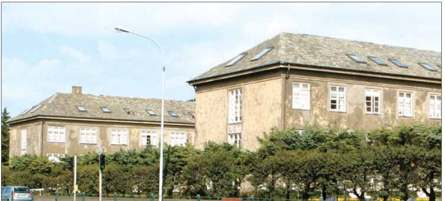
Aðalbygging Grundar við Hringbraut í vesturbæ Reykjavíkur. Elsti hluti hússins var tekinn í notkun árið 1930.
