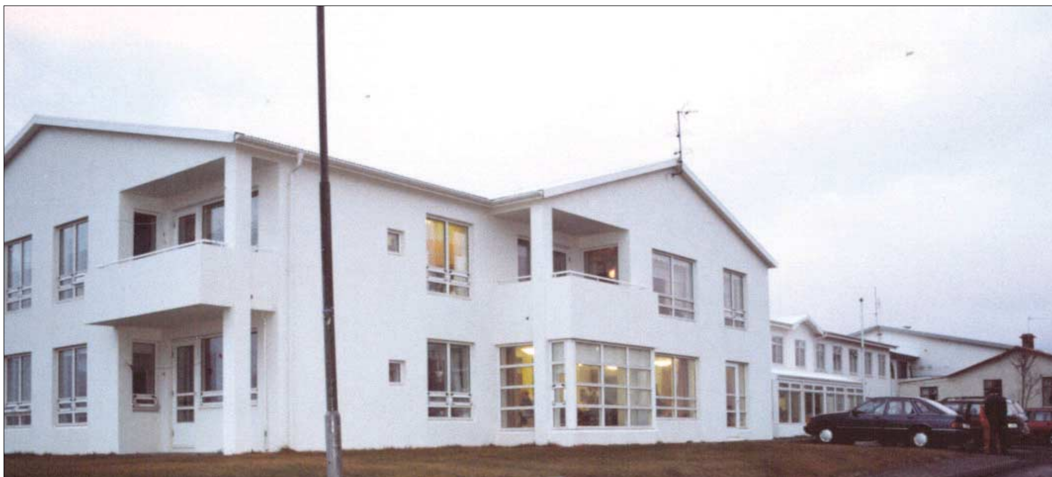
Dvalarheimili aldraðra í Stykkishólmi er til húsa í gamalli skólaheimavist, en þjónustuíbúðir hafa risið beggja vegna og eru húsin samtengd.
